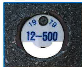
コンクリート柱の磁器製の銘板
