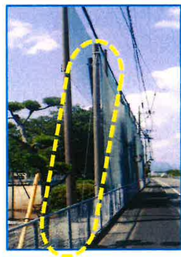
b 支線 防球ネットと逆側に主柱頂部から 斜めに出ているワイヤー。 地中にアンカーを設置。
