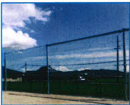
通常ジョイントビーム 柱の頂部をパイプ材でつなげている。 横梁のようなもの。
