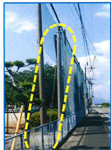
b 支線 防球ネットと逆側に主柱頂部から 斜めに出ているワイヤー。 地中にアンカーを設置。
