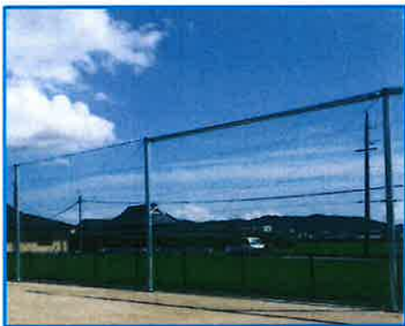
通常のジョイントビーム 柱の頂部をパイプ材でつなげている。 横梁のようなもの。
